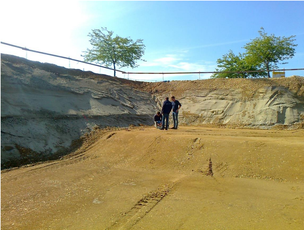
Abbildung 1: Baugrubensohle Wasserwerk Kittsee
