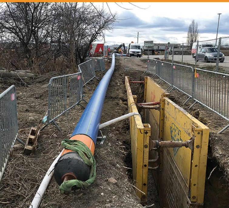
links, oben und unten: Das Berstlining-Verfahren erspart in der Anwendung Beeinträchtigungen für Anrainer und Zeit
