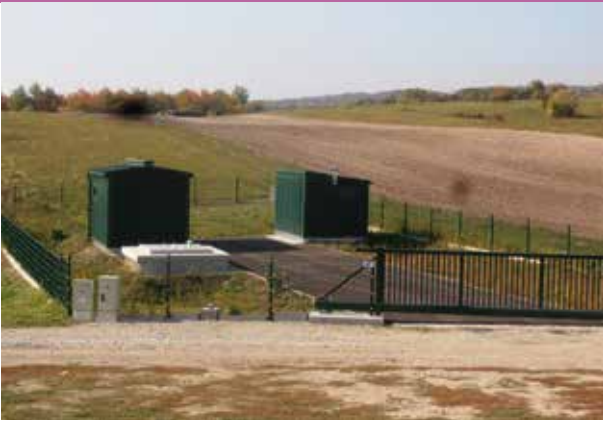
oben: neue Brunnenanlage in Winden rechts: Verlegung der Transportleitungen 152 und 153 bei Siegendorf und Zagersdorf
