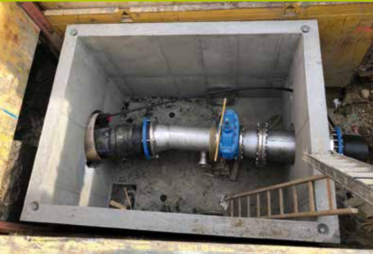
Bahnschacht-Querung mit Übergang von PE-RC in Niro DN400 inkl. Schieber und Entleerung (links). Schneckenbohrung DN800 in Stahl mit 25 lfm bei der ÖBB-Querung der TL102 in Purbach. (rechts).
