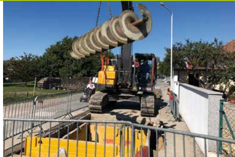
Bahnschacht-Querung mit Übergang von PE-RC in Niro DN400 inkl. Schieber und Entleerung (links). Schneckenbohrung DN800 in Stahl mit 25 lfm bei der ÖBB-Querung der TL102 in Purbach. (rechts).
