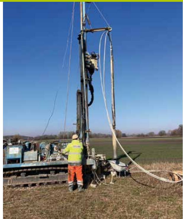
Erkundungs- und Brunnenbohrungen des Wasserleitungsverbands Nördliches Burgenland (WLV) dienen der Absicherung der Wasserversorgung im Burgenland (Bilder oben und unten).
