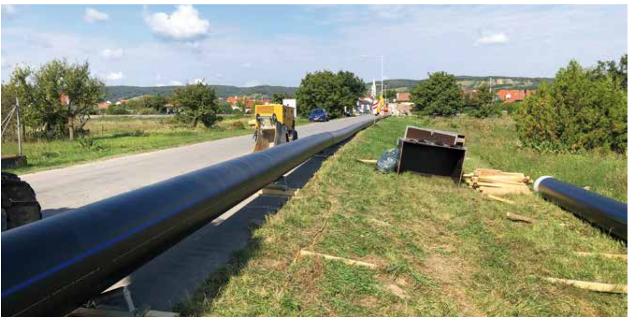
Vorgeschweißtes PE-RC Rohr für den Rohreinzug bei der Bahnquerung der TL102 in Purbach.
