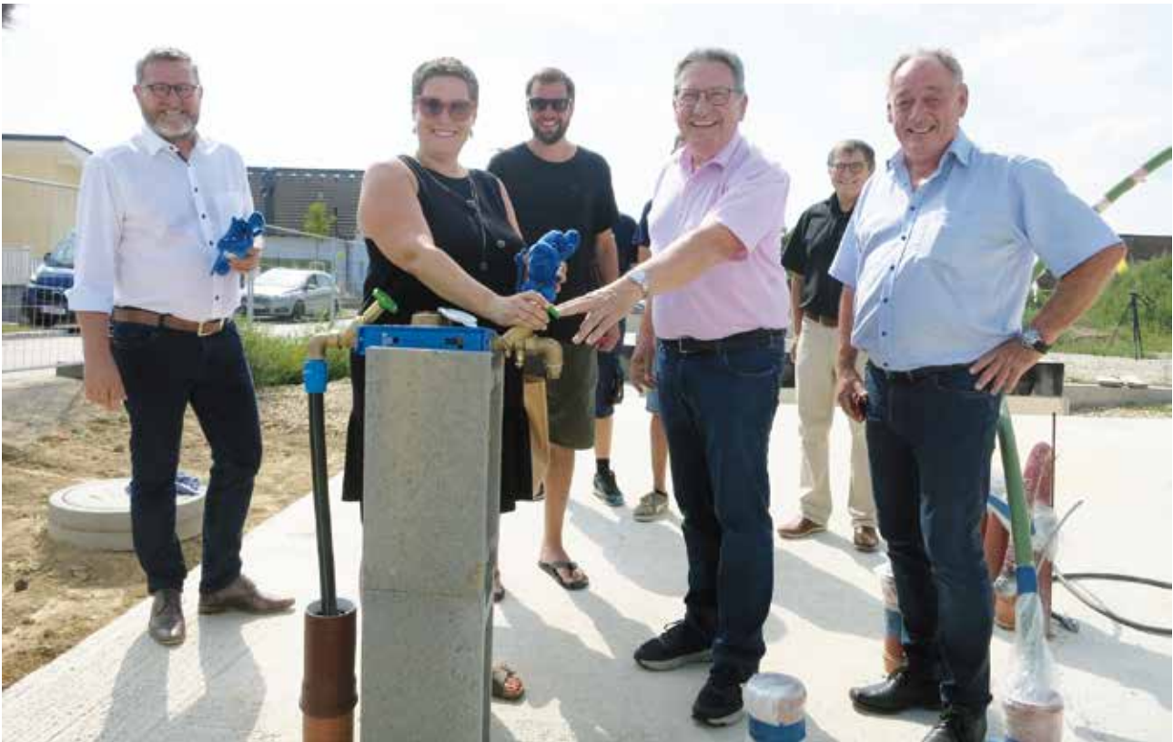
v. l. n. r.: Bürgermeister von Hirm Christian Wöhl, Kerstin Bedenik und Martin Puhm („Häuslbauer“), WLV-Obmann Bgm. Ing. Gerhard Zapfl, Technischer Betriebsleiter des WLVI Dr. Helmut Herlicska und LAbg. Bgm. Dieter Posch auf der Baustelle in Hirm
