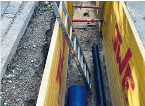
Rohrmix: Künette mit PE-RC DN/OD 160 mm neben GJS DN 300 mm
