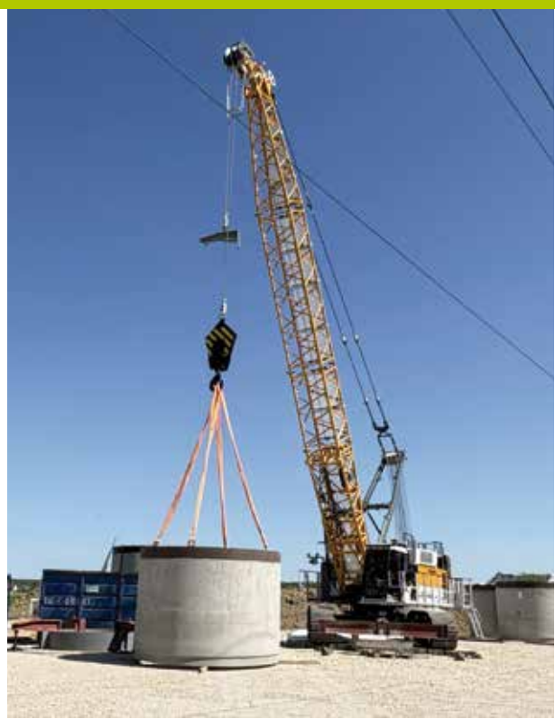
Mittels eines Seilbaggers (Bild links) wird Bodenmaterial aus dem Inneren des Brunnenschachtrings (Bild rechts), der auf den Stahlschneidring (Bild unten) aufgesetzt wurde, entfernt.
