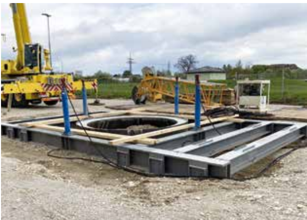
Als erster Schritt wurde ein Stahlschneidring auf die Bohrstelle aufgesetzt und ausbetoniert.
