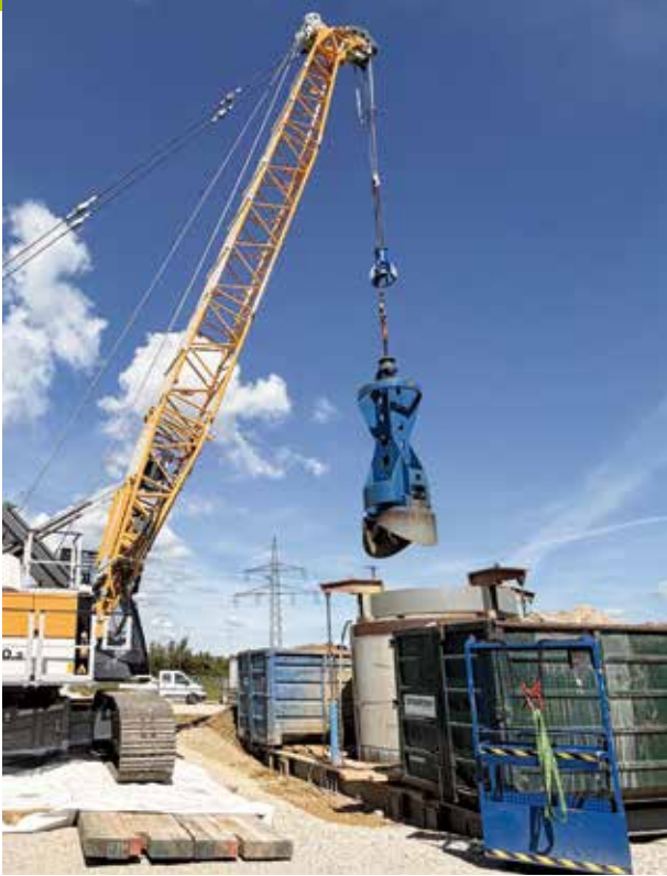
Mittels eines Seilbaggers (Bild links) wird Bodenmaterial aus dem Inneren des Brunnenschachtrings (Bild rechts), der auf den Stahlschneidring (Bild unten) aufgesetzt wurde, entfernt.
