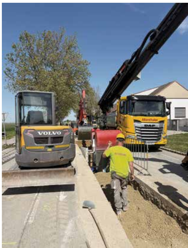
Verdichtungsarbeiten in einer Künette nach Rohrverlegung
