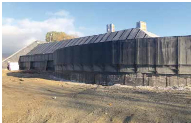
Phasen der Außensanierung des TB Purbach: Freilegen (links), überschütten (unten), abdichten (oben).
