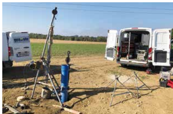
Erkundungsbohrung vor Errichtung des HFB 3 in Neudörf.
