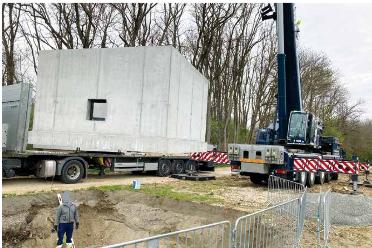
Ein wichtiger Schritt zu einem neuen Brunnen: Das Versetzen des Schachts mittels schwerem Gerät.
