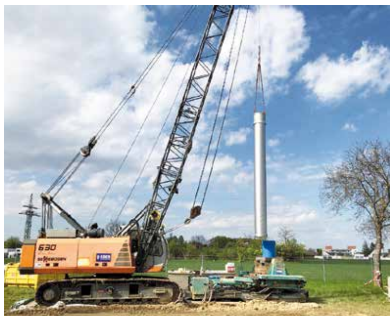
Einbau der Brunnenverrohrung
