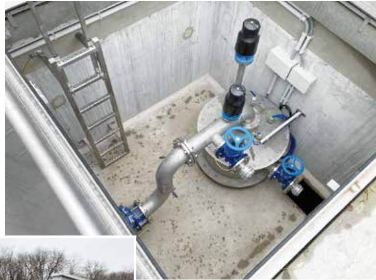
Schaltheis mit Wasserzählern (links oben), Schacht Brunnenausbau (oben) sowie Brunnen mit Schaltheis (links)
