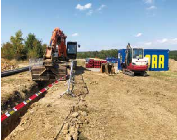
Baggerarbeiten im Zuge der Neuerrichtung der TL 177 in Loipersbach, Bezirk Mattersburg
