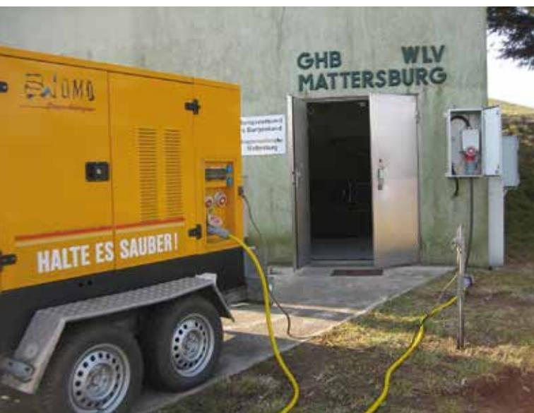
Mobiles Notstromaggregat im Einsatz bei Hochbehälter, Strom-Einspeisepunkt
