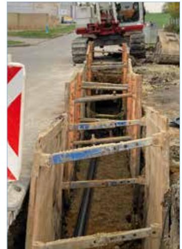
*oben und rechts: Verlege- und Wasserleitungsarbeiten im Bereich der „alten“ Wassertransportleitung TL004 zwischen St. Margarethen und Siegendorf.*
