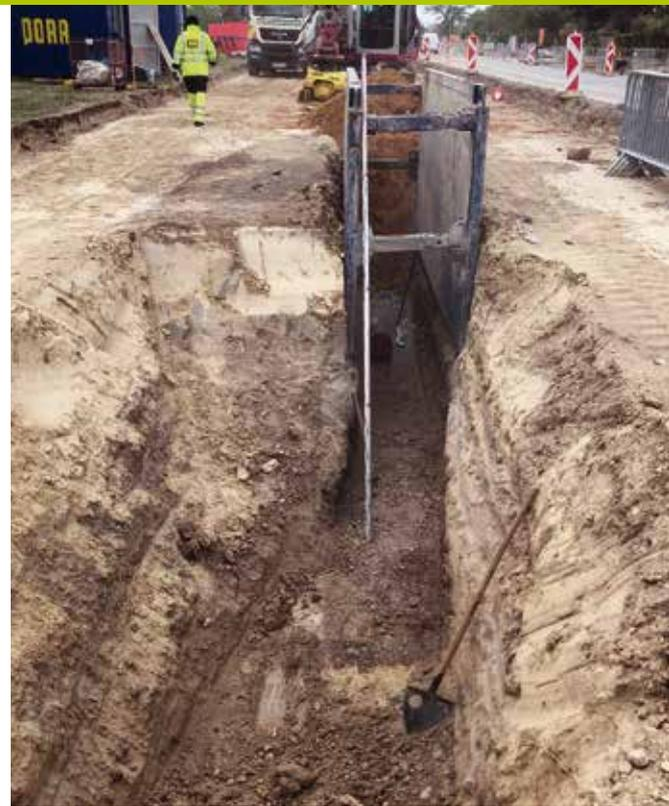
die angrenzenden Abschnitte der TL 005 und die TL 049 getauscht. Insgesamt wurden von der beauftragten Bau-firma ca. 1.600 lfm an Transportleitungen saniert. Die neuen Leitungen wurden als Gussleitungen mit Durchmesser DN 400 mm bzw. Gussleitungen DN 300 mm errichtet. Durch die Sanierung der Transportleitung wird die ausreichende Befüllung des GHB Seewinkel und damit auch des über die „Seeleitung“ angeschlossenen Leitungsnetzes des Seewinkels für die nächsten Jahrzehnte gesichert.
