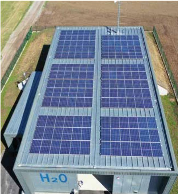
oben: Eine Photovoltaikanlage mit einer Leistung von 42 kWp sorgt auf dem Dach des neuen Wasserwerks Kittsee für die Abdeckung eines wesentlichen Teils des eigenen Strombedarfs.
