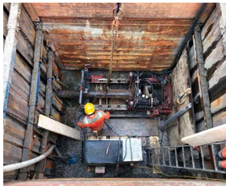
Bohrgrube samt Bohrgerät, das bei der Errichtung der TL018 in Marz zum Einsatz kommt.
