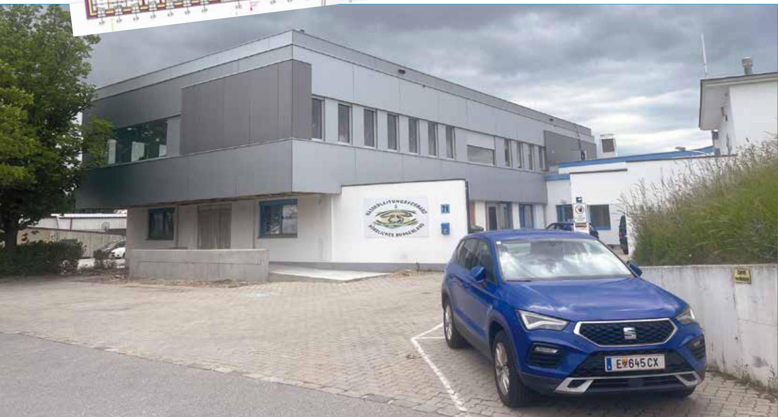
Eingangsbereich des aufgestockten WLVB-Standorts in Neusiedl am See
