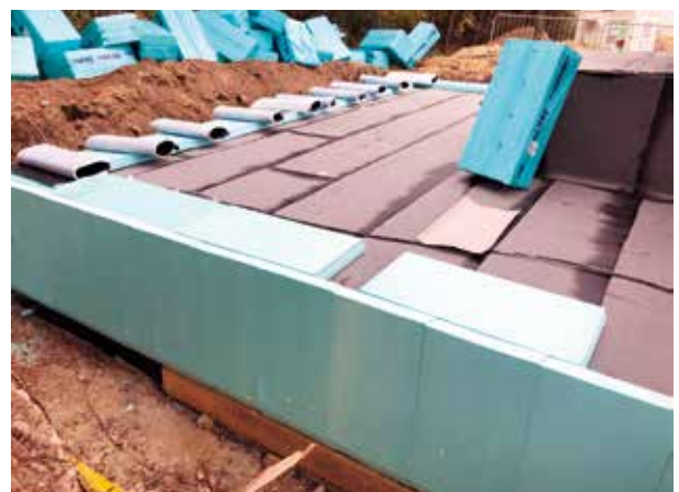
Der Hochbehälter St. Georgen I nach den Abdichtungs- und Dämmarbeiten
