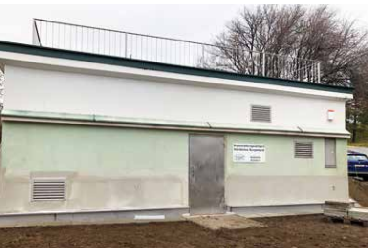
Der final wiederhergestellte Hochbehälter Müllendorf I nach Durchführung der Sanierungsarbeiten.
