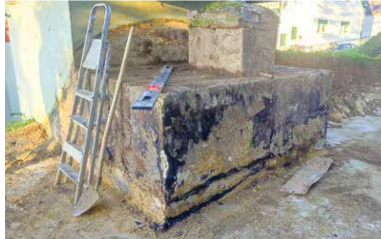
oben: Der freigelegte Hochbehälter St. Georgen I
