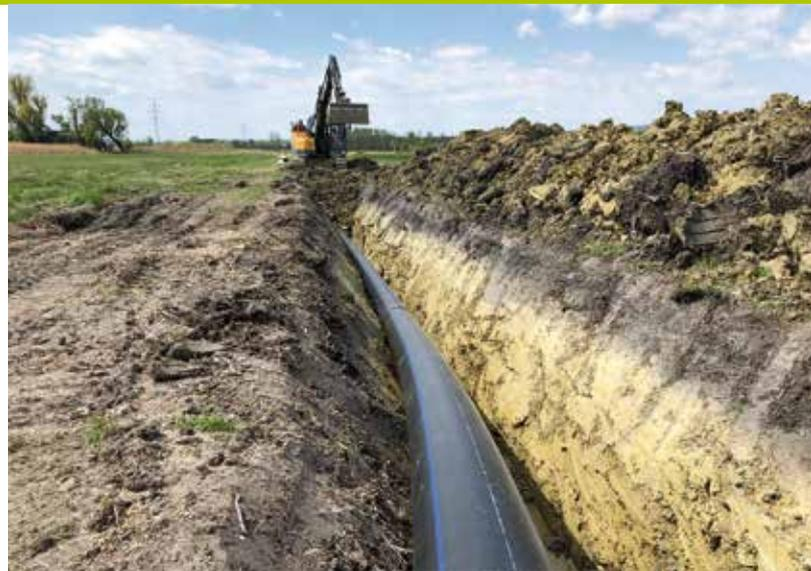
oben: Rohrverlegearbeiten im Zuge der Sanierung der TL 102 zwischen Donnerskirchen und Purbach
