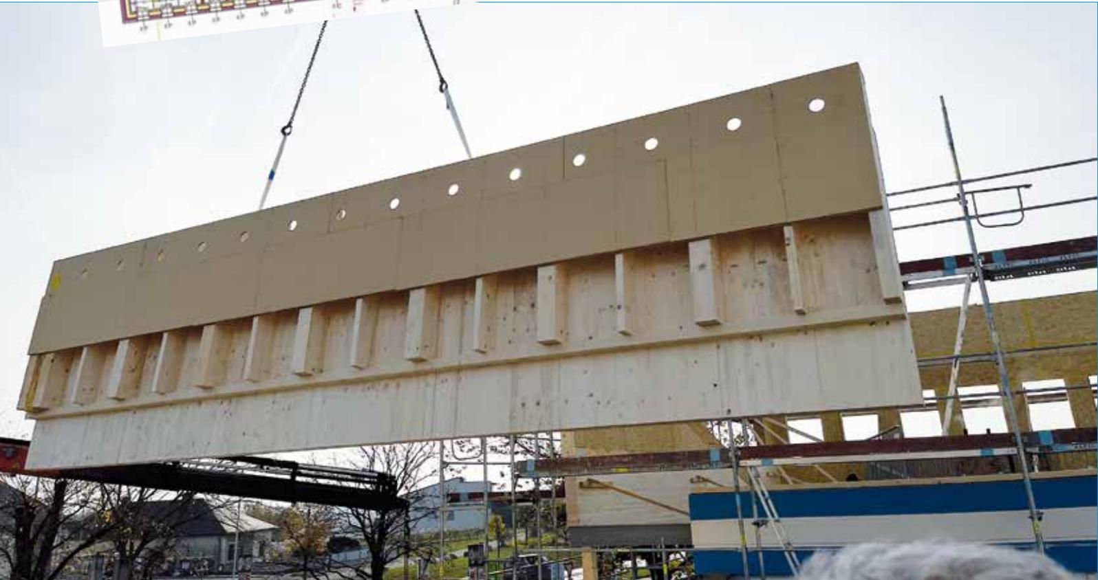
Plan und Holzfertigteil für die Aufstockung des WLW-Gebäudes der Außenstelle Neusiedl am See
