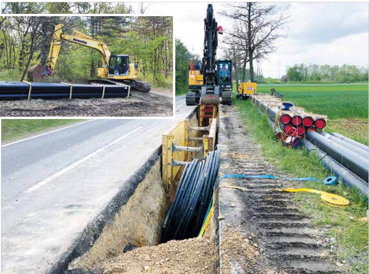
Impressionen von der WLW-Baustelle in Wimpassing.
