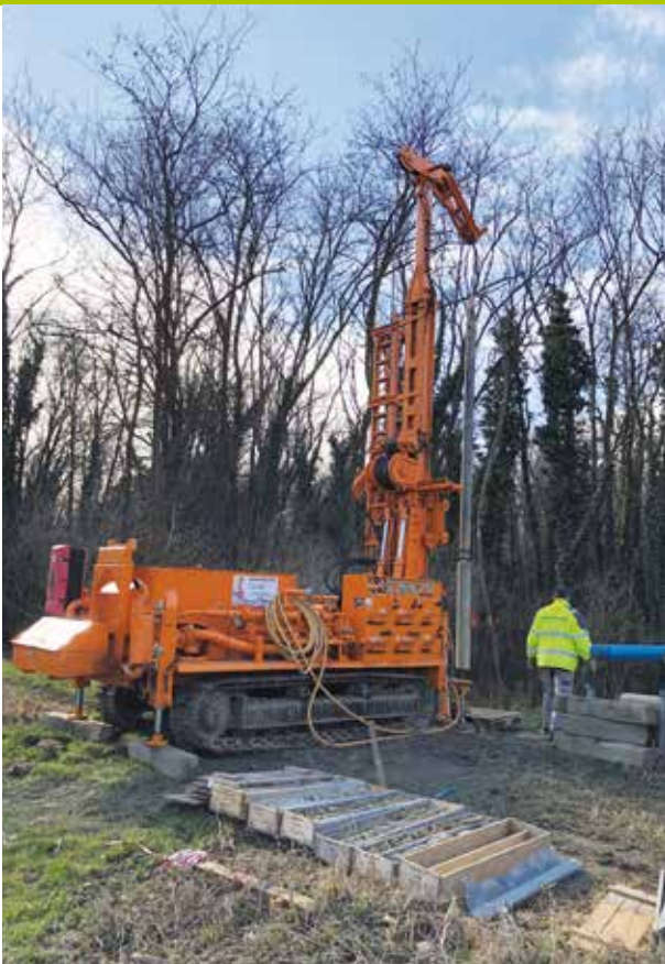
links: Rammkernbohrung in Wimpassing oben: Bohrerät für die Greiferbohrung unten: Grundwassermessstelle in Wimpassing
