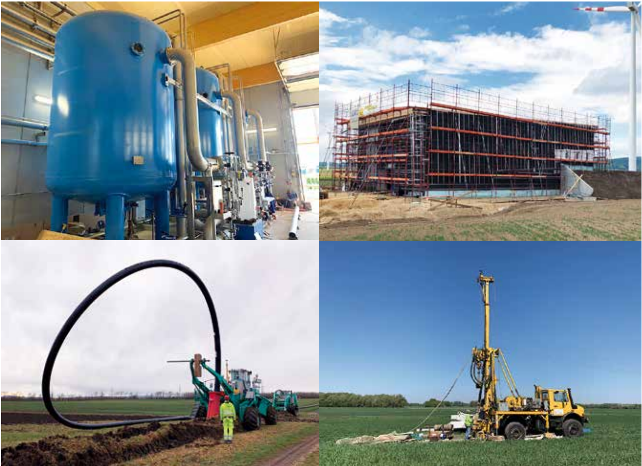
Investitionen des WLW in die Infrastruktur: Wasserwerk Kittsee (oben links und rechts), Pflugverlegung einer Wassertransportleitung beim Kleyhof (unten links) sowie Erkundungsbohrung bei Nickelsdorf (unten rechts)
