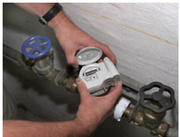
Hier ein Wasserzähler mit dem aufgesetzten Funkmodul, welches den Wasserzählerstand an den im Auto mitgeführten „Receiver“ überträgt und in weiterer Folge sofort ins Datensystem übernommen werden kann.
