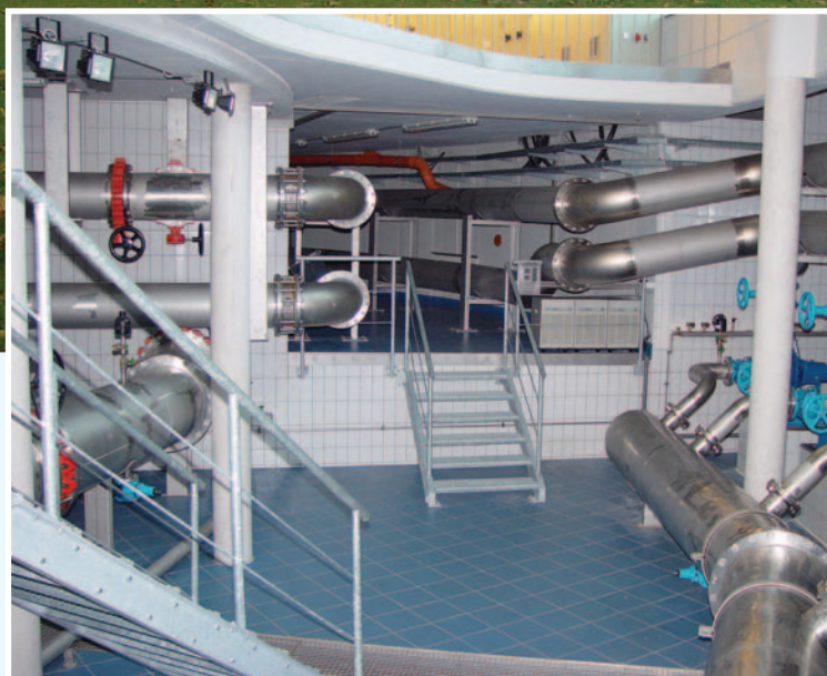
Brunnenanlage Neudörfel des Wasserleitungsverbands Nördliches Burgenland
