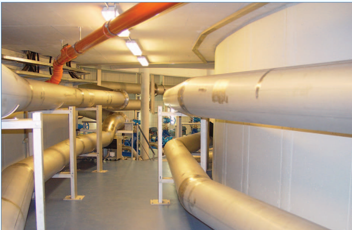
Nirostarohre im Innenbereich
